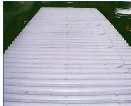
Das fertige, nahtlos beschichtete Wellplattendach.
