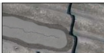
...mit Flüssigkunststoff beschichtet...
