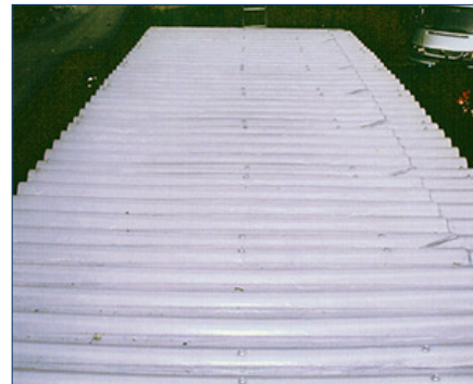
Das fertige, nahtlos beschichtete Wellplattendach.
